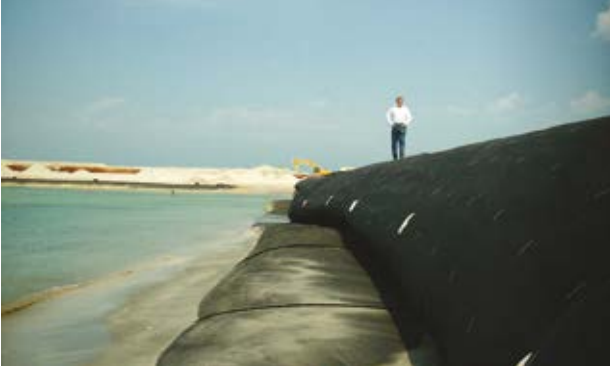
Bu koruyucu yapıyı oluşturmak için TenCate Geotube® sistemleri yığılmıştır.
