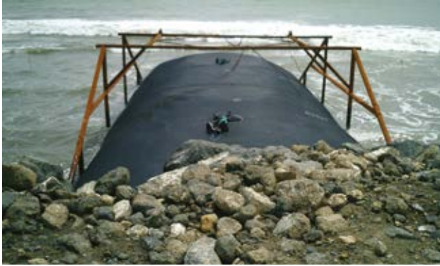
TenCate Geotube® sistemi doldurulurken çelik çerçeve ile sabit tutuluyor.
