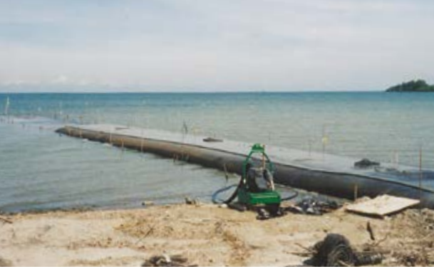
Karides çiftliği girişi için dalgakıran oluşturmak amacıyla konumlandırılmış TenCate Geotube® sistemleri.
