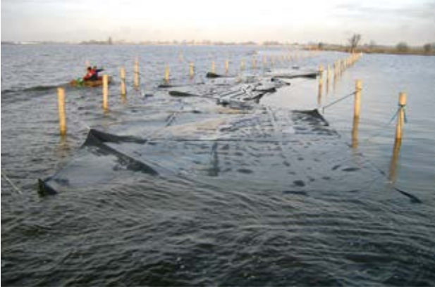
Kumla doldurulmaya hazır TenCate Geotube® sistemi.
