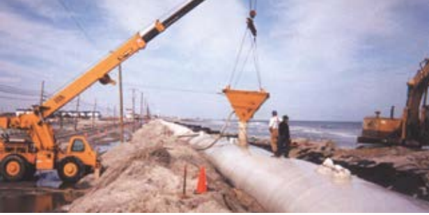
TenCate Geotube® sistemi vinç kullanarak kum ile doldurulurken.
